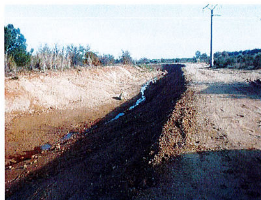
Secteur amont après travaux
