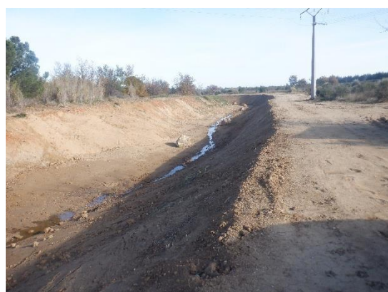
Secteur amont après travaux
