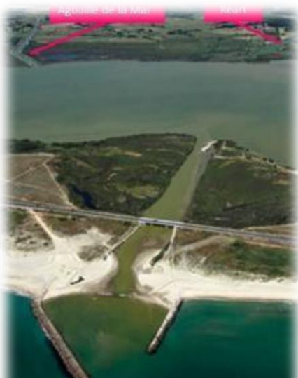
Figure 9 Grau des Basses (Exutoire de l'Étang)
