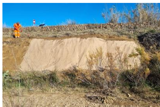
Bâche pour éviter la nidification avant travaux
