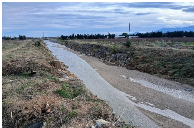
Débroussaillage des digues sur le linéaire de digues
